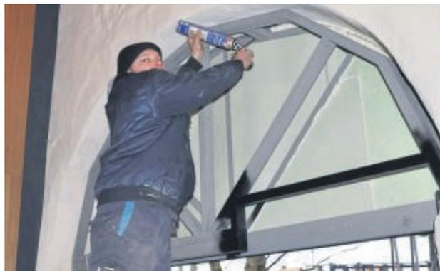
**An dem bereits gesetzten Rahmen** wird später das brünierte Messingteil angebracht. Maximilian Beintinger dichtet die offenen Stellen mit Füllmaterial ab.
