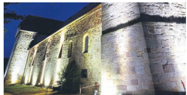
Beleuchtete Stiftskirche nach der Sanierung.
