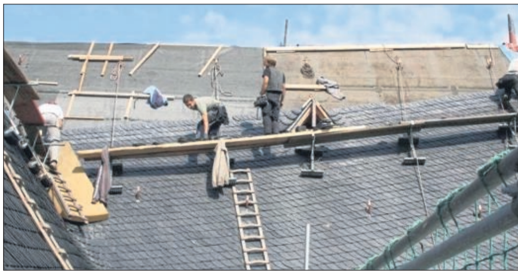
Kleine Bauteile, große Wirkung: Rund 2000 Quadratmeter Dachfläche wurden mit Schieferplatten neu eingedeckt. Laut Burischek lief das ziemlich routiniert ab. Durchatmen war trotzdem angesagt: „Dann kam kein Wasser mehr rein.“
