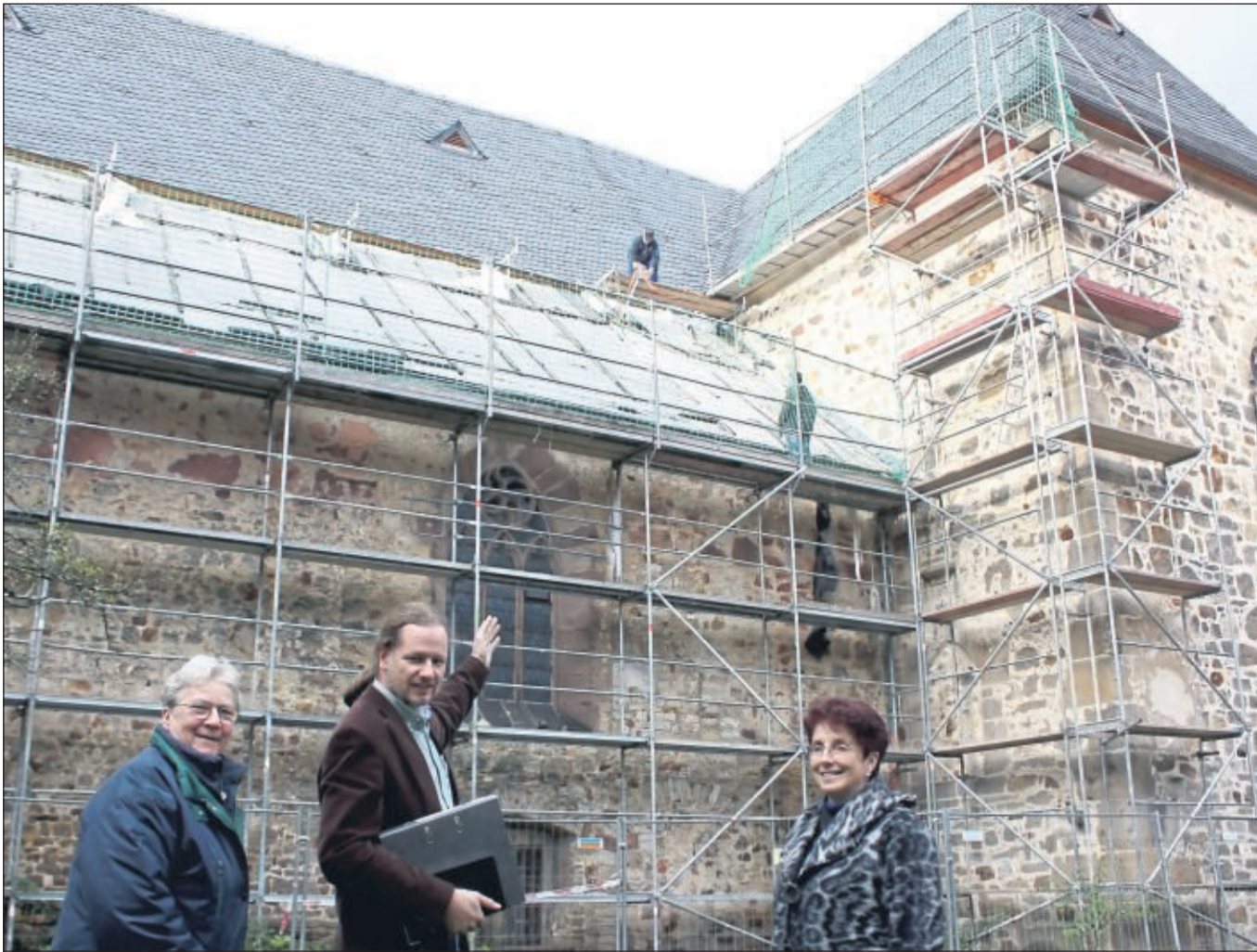
Eingerüstete Kirche: Ingenieur für Architektur Martin Burischek steht mit Silke Does vom Kirchenvorstand (links) und Dekanin Carmen Jelinek am Mittelschiff der Stiftskirche. Unser Foto zeigt das Gotteshaus während der Hauptbauphase im Jahr 2012.
