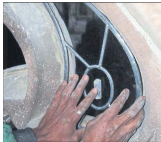
Feinarbeit: Neue Fenster mit Bleistruktur wurden eingebaut. Fakt am Rande: Der Mörtel, der die Fassung für die Bleistruktur bildet, wird mit Schweinsborsten vermischt. „Das schafft Elastizität“, erläutert der Ingenieur.
